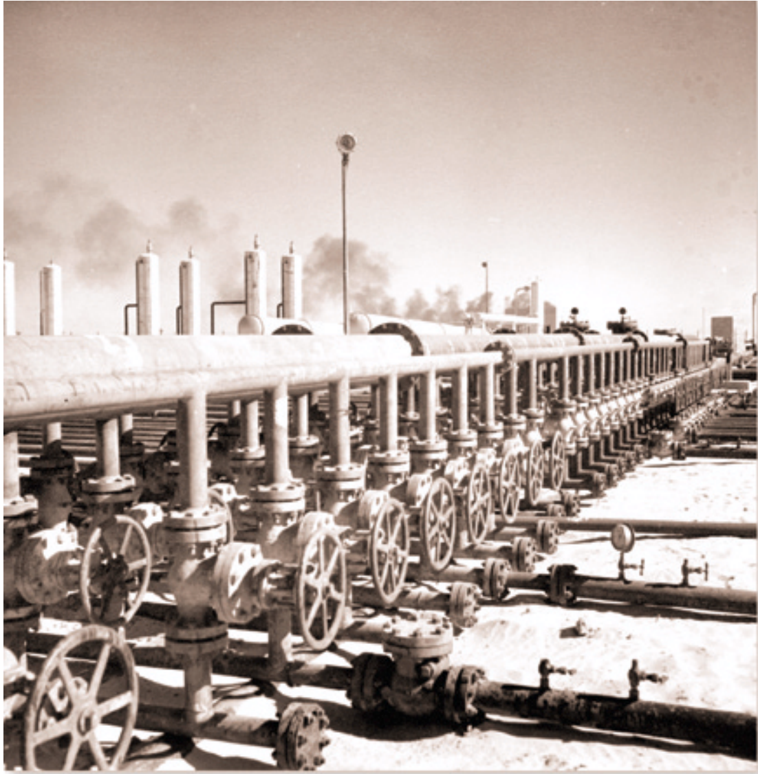
برقان - مشعبات خط تدفق في مراكز التجميع - ١٩٤٩/١٢/٣١ Burgan - flowline manifolds at gathering centre - 31-12-1949
